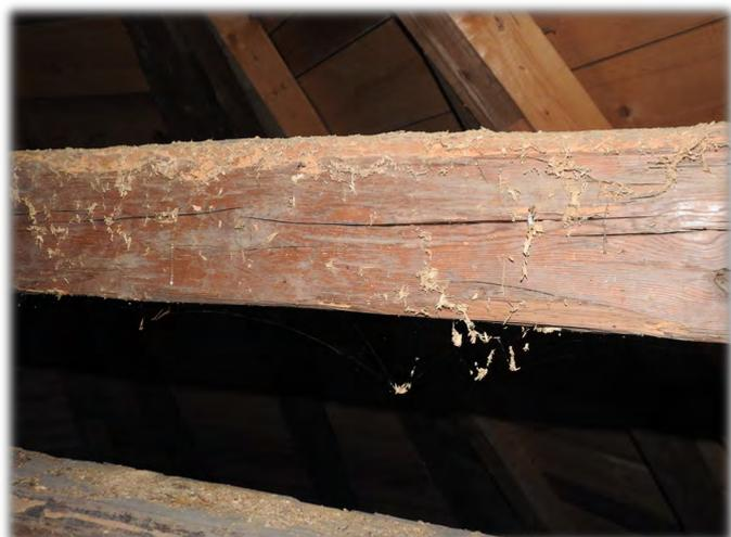
Außerdem sind ein paar Knotenpunkte der Dachstuhlkonstruktion desolat und somit zu erneuern bzw. zu verstärken.
